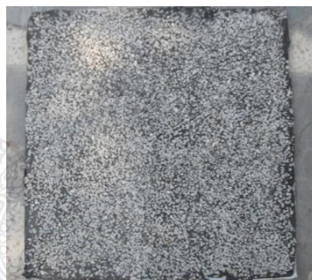
รูปที่ 4 หลังคายางมะตอยชนิด PMA ผสมน้ำยางธรรมชาติ
