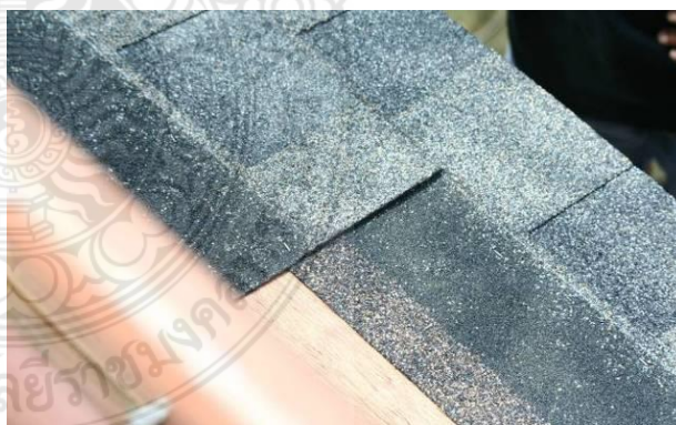
รูปที่ 2 การติดตั้งแผ่นหลังคาขางมะตอย
