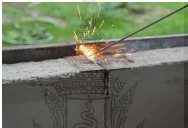
รูปที่ 18 การเชื่อมผนังคอนกรีตสำเร็จรูปมวลเบาเสริมแผ่นโพนอัดแน่นทั้งสองแผ่นให้ยึดติดกัน
