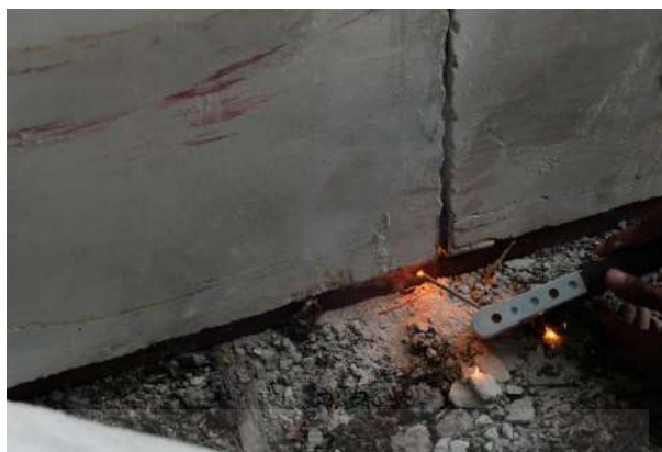
รูปที่ 4.25 การเชื่อมผนังคอนกรีตสำเร็จรูปมวลเบาเสริมแผ่นโพลีเอทเธนให้เข้ากันสนิท
