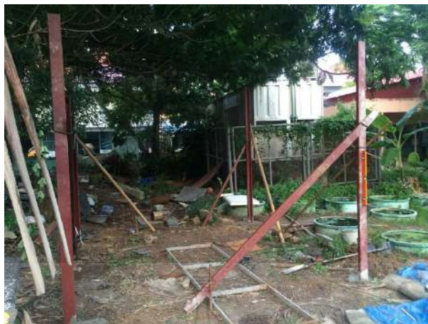
รูปที่ 4.16 การตั้งเสาหลักเพื่อติดตั้งผนังคอนกรีตสำเร็จรูปมวลเบาเสริมแผ่นโฟมอัดแน่น
