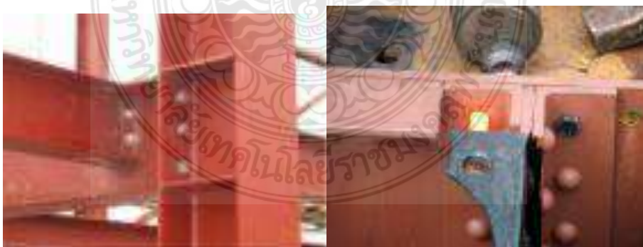
รูปที่ 2.3 รอยต่อของเหล็กรูปพรรณ
