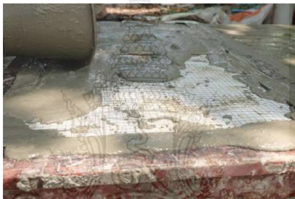
รูปที่ 3.32 การเทมอร์ตาร์ลงบนแผ่นผนังคอนกรีตสำเร็จรูปมวลเบาเสริมแผ่นโฟมอัดแน่น
