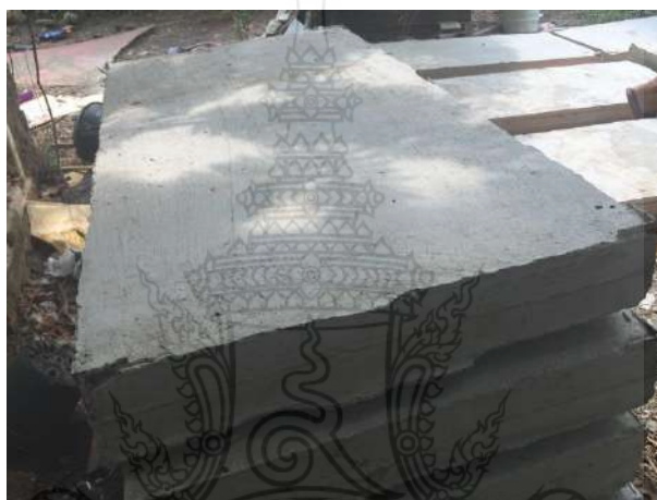
รูปที่ 4.1 ขอบของผนังคอนกรีตสำเร็จรูปมวลเบาเสริมแผ่นโพนัดแน่นที่บางแผ่นอาจมีน้ำปูนแข็งตัวซึ่งก็สามารถกะเทาะออกไปได้
