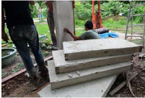
รูปที่ 17 การจัดผนังคอนกรีตสำเร็จรูปมวลเบาเสริมแผ่นโพนอัดแน่นให้เข้ามุม
