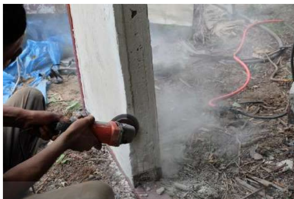
รูปที่ 4.22 การตัดแต่งผิวของผนังคอนกรีตสำเร็จรูปมวลเบาเสริมแผ่นโพนัดแน่น
