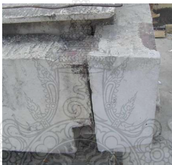
รูปที่ 2.29 ลักษณะการเชื่อมต่อของคานหลักกับคานชอย
