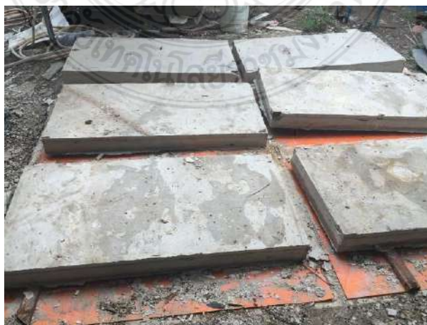
รูปที่ 3.36 การรอนผนังคอนกรีตสำเร็จรูปมวลเบาเสริมแผ่นโฟมอัดแน่นให้เซตตัว
