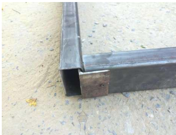
รูปที่ 3.10 การถอด-ประกอบแบบหล่อผนังคอนกรีตสำเร็จรูป
