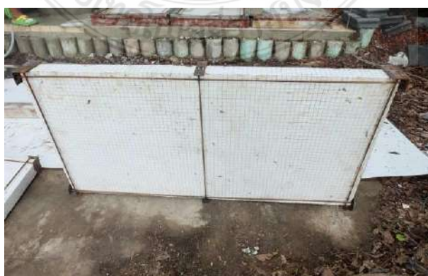
รูปที่ 3.21 การวางแนวเหล็กของผนังคอนกรีตสำเร็จรูปมวลเบาเสริมแผ่นโฟมอัดแน่นด้านนอน
