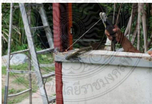
รูปที่ 4.21 การเชื่อมผนังคอนกรีตสำเร็จรูปมวลเบาเสริมแผ่นโฟมอัดแน่นชั่วคราว
