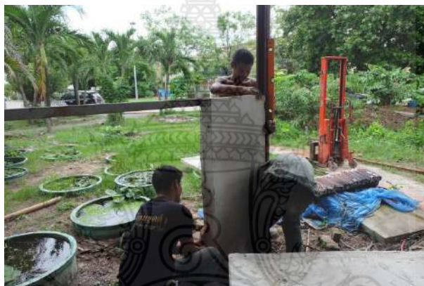
รูปที่ 4.17 การเรียงผนังคอนกรีตสำเร็จรูปมวลเบาเสริมแผ่นโฟมอัดแน่นเข้ากับเสาหลัก
