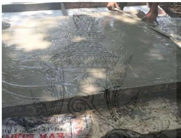
รูปที่ 3.35 การฉาบผนังคอนกรีตสำเร็จรูปมวลเบาเสริมแผ่นโฟมอัดแน่นให้เรียบ
