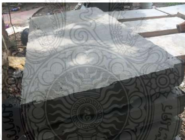
รูปที่ 9 ขอบของผนังคอนกรีตสำเร็จรูปมวลเบาเสริมแผ่นโพน้ออัดแน่นที่บางแผ่น อาจมีน้ำปูนแข็งตัวซึ่งก็สามารถแกะออกไปได้
