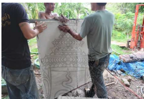
รูปที่ 4.23 การติดตั้งผนังคอนกรีตสำเร็จรูปมวลเบาเสริมแผ่นโพนัดแน่นแผ่นต่อไป
