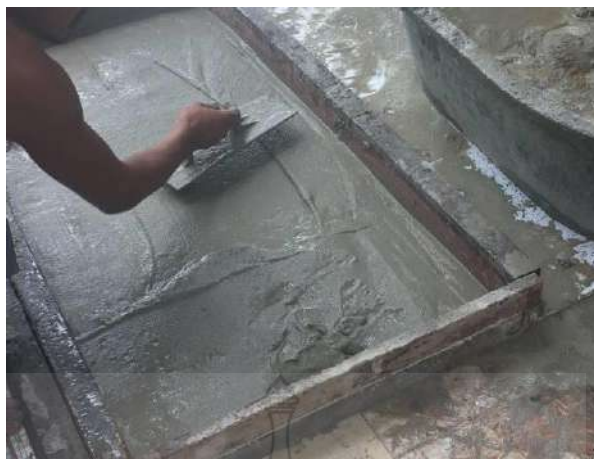
รูปที่ 3.25 การเทมอร์ตาร์เพื่อติดตั้งแผ่นโคมอัดแน่น
