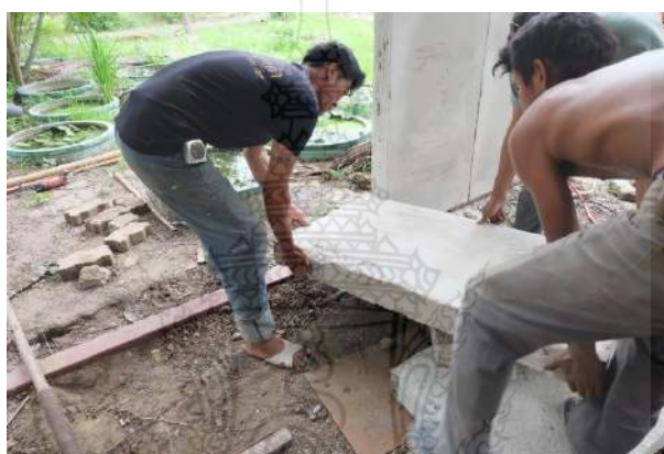
รูปที่ 4.26 การยกแผ่นผนังคอนกรีตสำเร็จรูปมวลเบาเสริมแผ่นโพลีเอทเธนมาติดตั้งต่อไป
