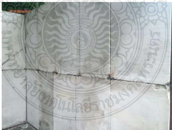
รูปที่ 19 ผนังคอนกรีตสำเร็จรูปมวลเบาเสริมแผ่นโพนอัดแน่นก่อนการฉาบร่อง
