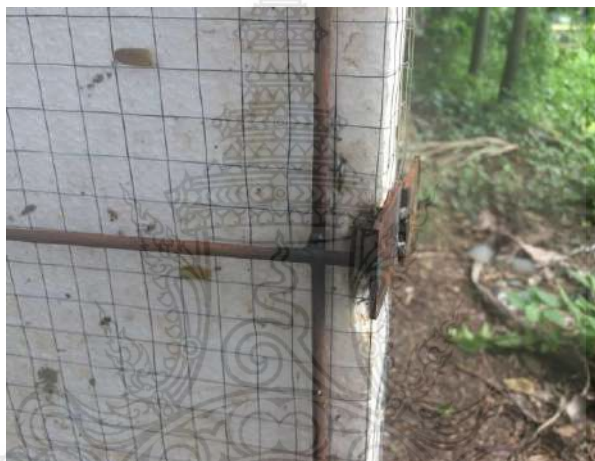
รูปที่ 3.23 แนวเหล็กส่วนกลางของผนังคอนกรีตสำเร็จรูปมวลเบาเสริมแผ่นโฟมอัดแน่น
