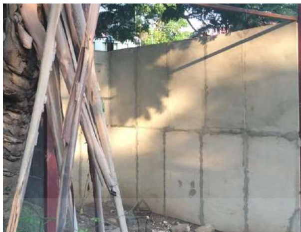
รูปที่ 20 ผนังคอนกรีตสำเร็จรูปมวลเบาเสริมแผ่นโพน้อทนไฟภายหลังจากการฉาบร่อง
