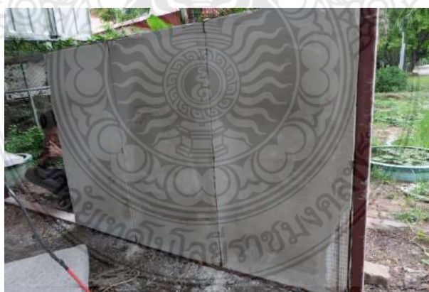
รูปที่ 4.27 ผนังคอนกรีตสำเร็จรูปมวลเบาเสริมแผ่นโพลีเอทเธนที่ถูกเชื่อมติดกัน
