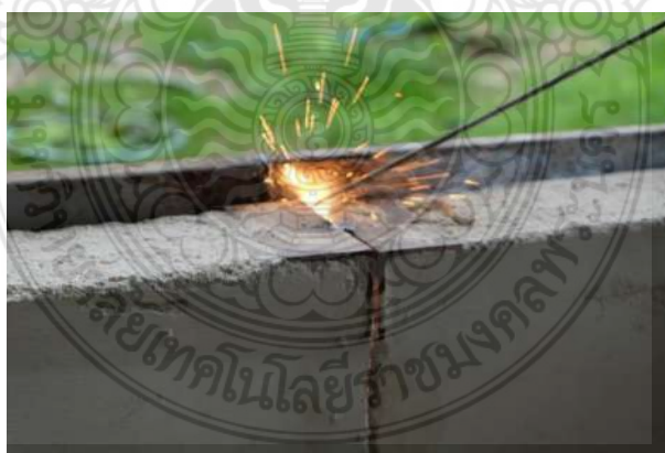
รูปที่ 4.24 การเชื่อมผนังคอนกรีตสำเร็จรูปมวลเบาเสริมแผ่นโพนัดแน่นทั้งสองแผ่นให้ยึดติดกัน
