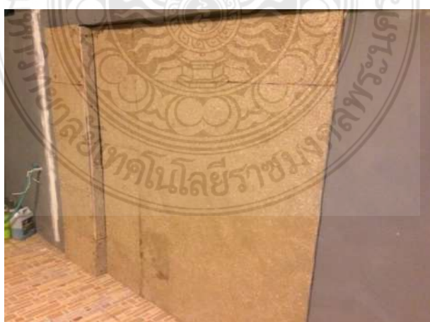
รูปที่ 4.23 ผนังที่ตกแต่งด้วยแผ่นไม้เทียมจากเศษกระดาดاخل่องนมผสมเศษพลาสติก PET
