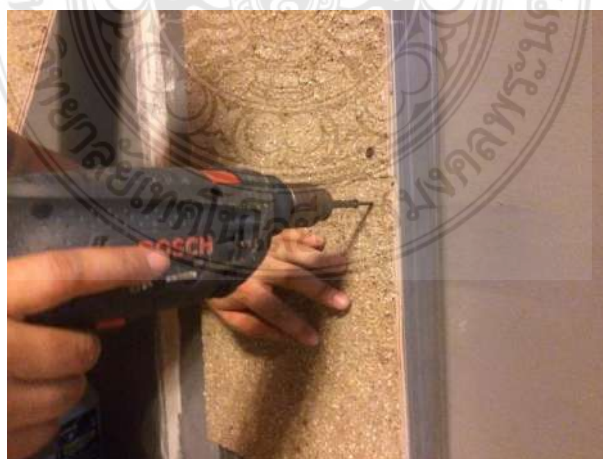
รูปที่ 4.20 การยึดแผ่นไม้เทียมจากเศษกระดาษกล่องนมผสมเศษพลาสติก PET เข้ากับโครงคร่าว
