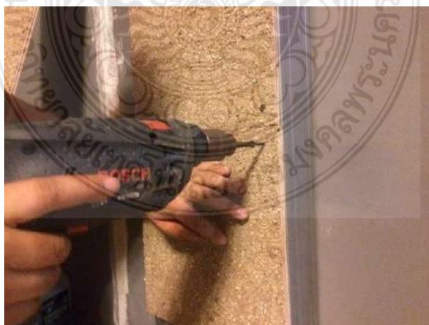
รูปที่ 31 การยึดแผ่นไม้เทียมจากเศษกระดาษกล่องนมผสมเศษพลาสติก PET เข้ากับโครงคร่าว
