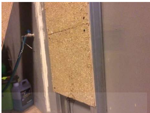
รูปที่ 4.21 แผ่นไม้เทียมจากเศษกระดาดاخل่องนมผสมเศษพลาสติก PET ที่ยึดเข้ากับโครงคร่าว
