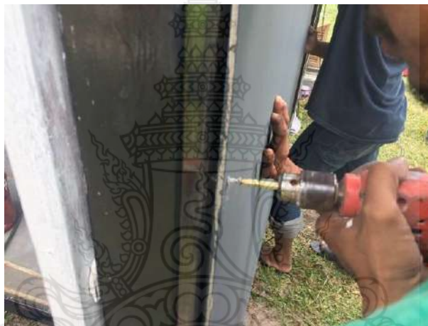
รูปที่ 4.58 การยึดแผ่นผนังที่เว้นช่องหน้าต่างไว้แล้วเข้ากับโครงผนังด้วยตะปูเกลียวปลายป่อย
