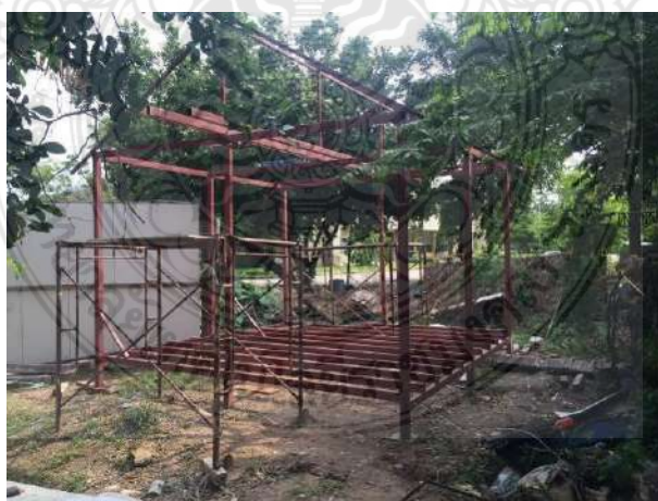
รูปที่ 4.18 การประกอบส่วนของโครงหลังคา ทั้งดั่ง ออกไก่ และจันทัน
