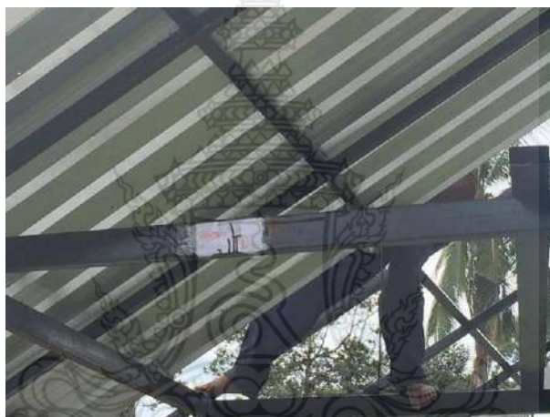
รูปที่ 4.47 แผ่นหลังคาเหล็กที่ถูกยึดเข้ากับโครงสร้างหลังคาด้วยตะปูเกลียวที่มียางรองการรั่วซึม
