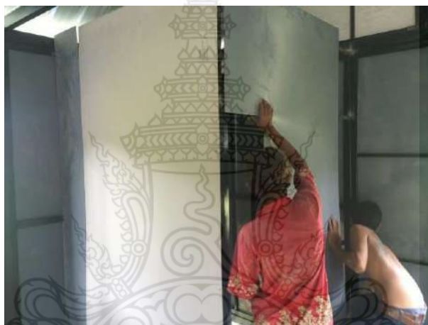
รูปที่ 4.61 การยึดแผ่นผนังด้านในของห้องน้ำเข้ากับโครงผนังของบ้านถอดประกอบ
