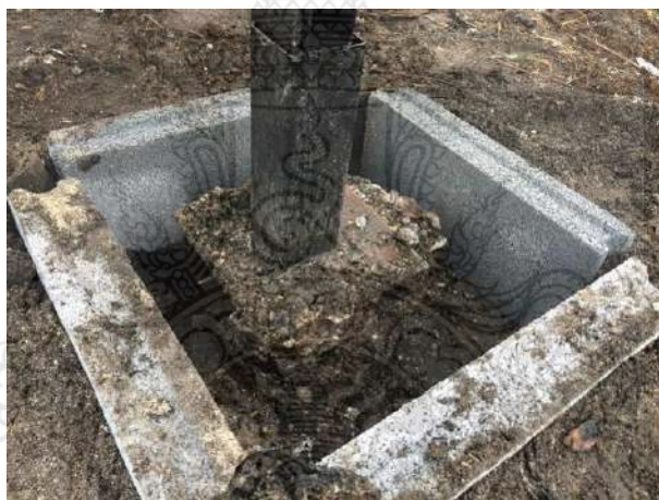
รูปที่ 4.39 การวางตอม่อลงบนฐานรากชั่วคราวก่อนการหล่อฐานรากด้วยคอนกรีต
