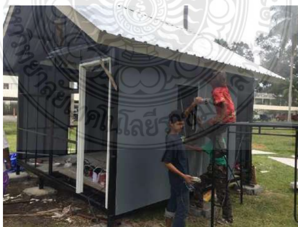
รูปที่ 4.59 การยึดแผ่นผนังให้ครอบคลุมโครงที่ออกแบบไว้
