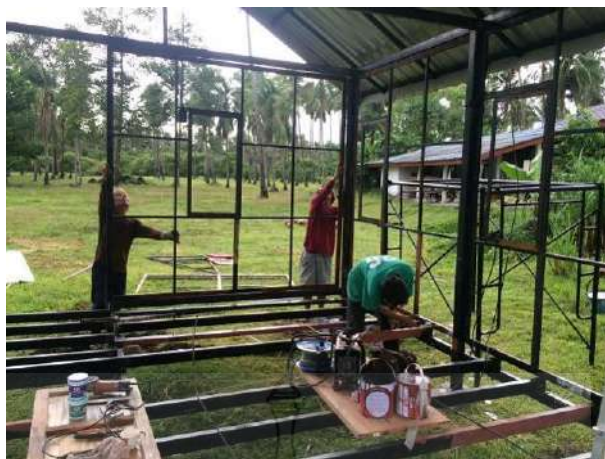
รูปที่ 4.49 การใช้สลักเกลียวยึดโครงผนังเข้ากับเสาและคานของบ้านถอดประกอบ
