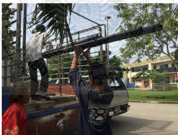
รูปที่ 4.28 การยกโครงสร้างคานและตงของบ้านถอดประกอบขึ้นรถบรรทุก 6 ล้อ
