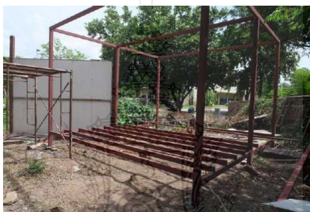
รูปที่ 4.17 การประกอบตงเหล็กเพื่รองรับแผ่นพื้นของโครงสร้าง
