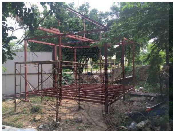
รูปที่ 8 การประกอบส่วนของโครงหลังคา ทั้งตั้ง ออกไก่ และจันทัน
