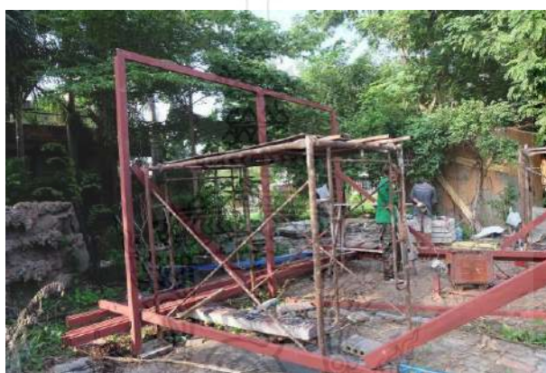
รูปที่ 4.14 การประกอบส่วนของอะเสเหล็กลงบนเสาเหล็กทั้ง 3 เสา
