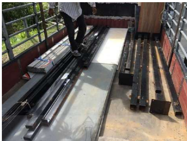
รูปที่ 4.29 การจัดเรียงโครงสร้างของบ้านถอดประกอบขึ้นรถบรรทุก 6 ล้อ
