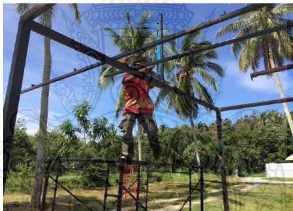
รูปที่ 4.44 การเตรียมติดตั้งออกไก่บนดั่งของโครงสร้างหลังคา
