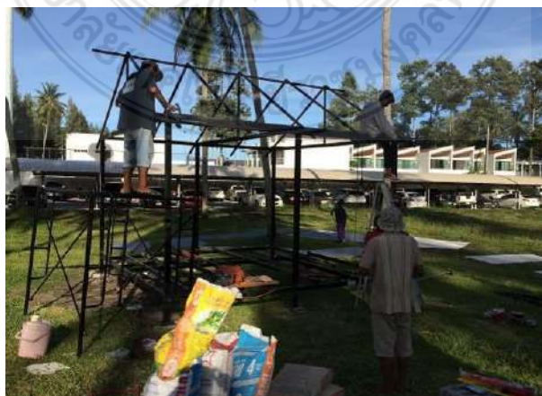
รูปที่ 4.45 การติดตั้งดั่ง ออกไก่ และจันทันของโครงสร้างหลังคาเรียบร้อยแล้ว
