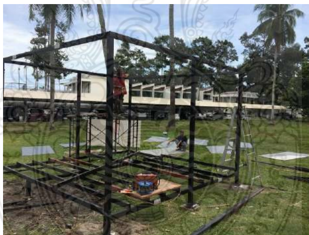
รูปที่ 15 โครงสร้างบ้านถอดประกอบที่มีการติดตั้งคาน ตง ช่อ และอะเส เรียบร้อยแล้ว
