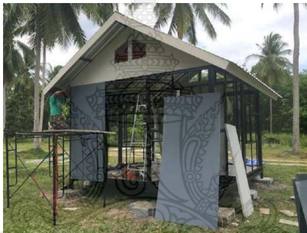
รูปที่ 4.55 การติดตั้งแผ่นผนังเข้ากับโครงผนังของบ้านถอดประกอบที่ขนส่งสะดวกเพื่อผู้ประสบภัย
