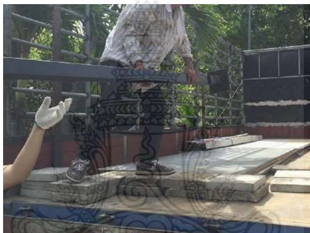
รูปที่ 4.27 การยกโครงสร้างเสาของบ้านถอดประกอบขึ้นรถบรรทุก 6 ล้อ ภายหลังจากแผ่นพื้นและผนัง
