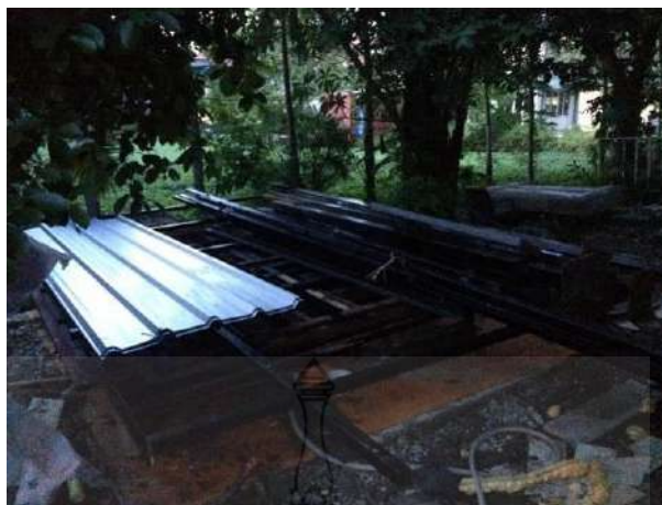
รูปที่ 4.25 กองโครงสร้างบ้านถอดประกอบที่เก็บไว้เพื่อนำไปประกอบ
