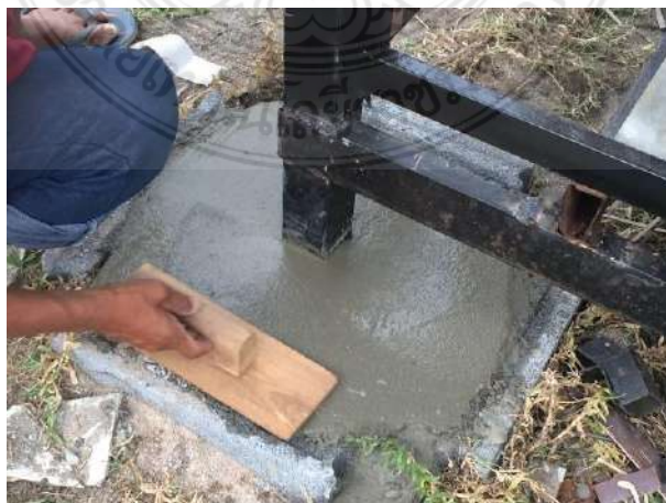
รูปที่ 4.40 การเทฐานรากหุ้มแผ่นเหล็กและโคนเสาตอม่อเหล็กด้วยคอนกรีตเสริมเหล็ก
