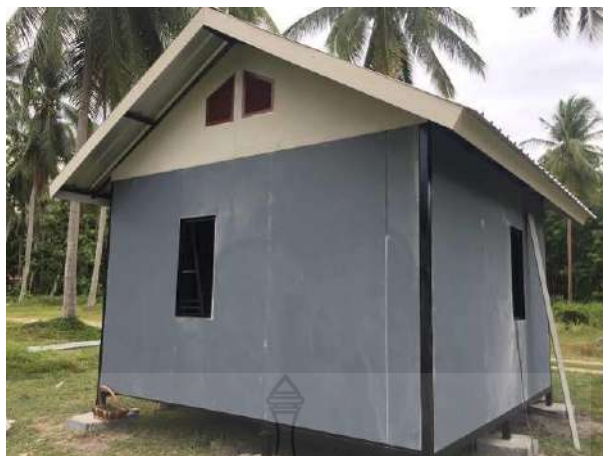
รูปที่ 4.60 การยึดแผ่นผนังเข้ากับโครงผนังของบ้านถอดประกอบทุกด้าน
