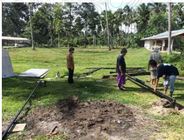
รูปที่ 4.37 การปรับพื้นที่ก่อสร้างบ้านถอดประกอบให้เรียบ
