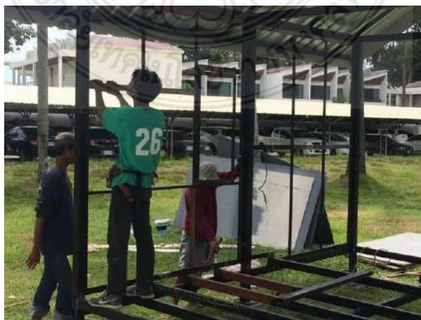
รูปที่ 4.48 การติดตั้งโครงผนังเข้ากับคานและเสาของบ้านถอดประกอบ
