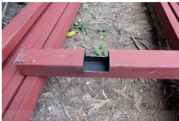
รูปที่ 4.7 การบากเสาเหล็กให้เป็นร่องเพื่อติดตั้งส่วนของคานเหล็ก
