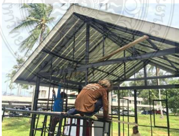
รูปที่ 4.51 การติดตั้งโครงหน้าจั่วของบ้านถอดประกอบที่ขนส่งสะดวกเพื่อผู้ประสภภัย
