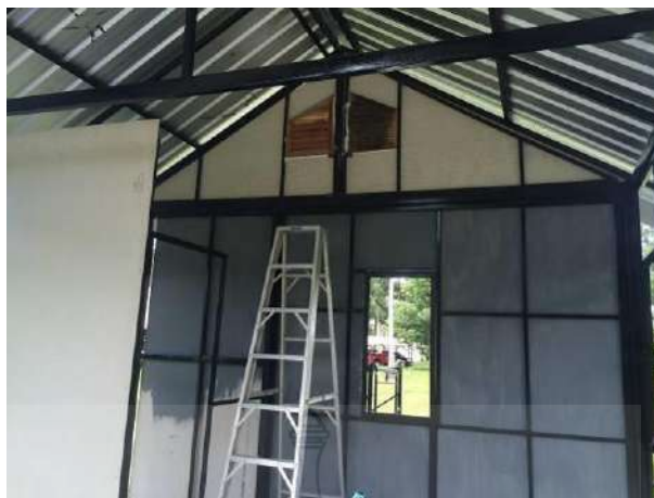
รูปที่ 4.57 การติดตั้งแผ่นผนังด้านในบ้านถอดประกอบสำหรับแบ่งเป็นห้องน้ำ
