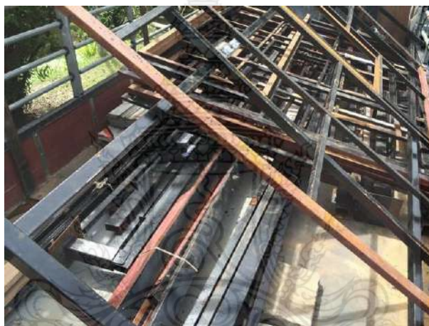
รูปที่ 4.30 การวางโครงผนังพาดเอียงตามแนวกระบะของรถบรรทุก 6 ล้อ
