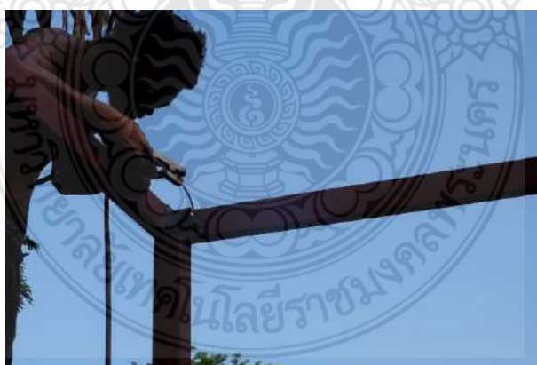
รูปที่ 4.15 การเชื่อมเหล็กฉากในส่วนของอะเส ชี้อ และเสาเหล็กให้สามารถร้อยสลักเกลียวติดกันได้
