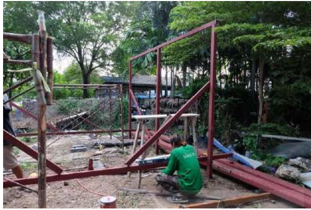
รูปที่ 7 การตั้งเสาเหล็กและคานเหล็กให้ได้ระดับ
