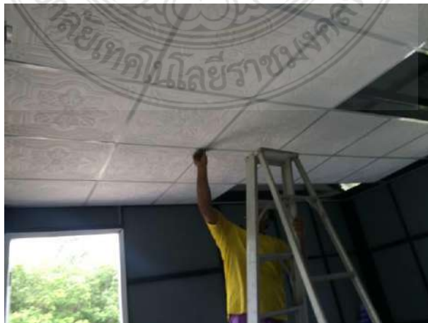
รูปที่ 23 การติดตั้งฝ้าเพดานโดยใช้โครงอะลูมิเนียมแบบทีบาร์และแผ่นฝ้าเพดานยิปซัม
