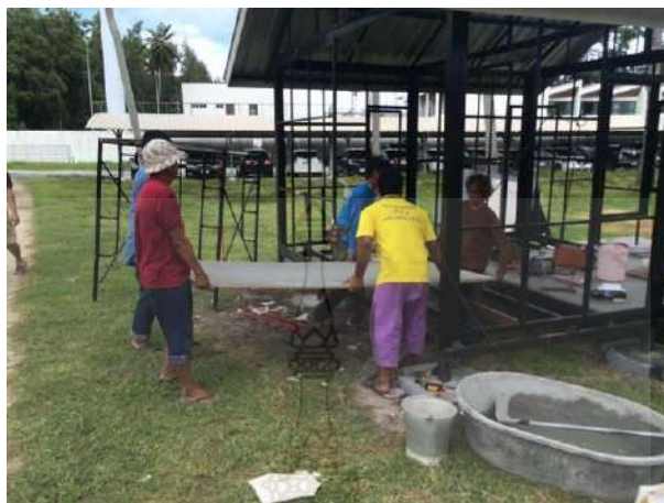
รูปที่ 4.52 การติดตั้งแผ่นพื้นโดยใช้แผ่นซีเมนต์บอร์ดยึดเข้ากับตงและคานเหล็ก
