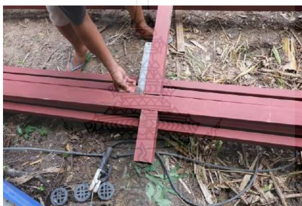
รูปที่ 4.8 การทดลองวางแนวคานเหล็กลงในเสาเหล็กที่บากร่องไว้
