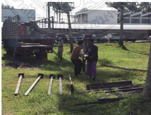
รูปที่ 4.34 การนำโครงสร้างบ้านถอดประกอบลงจากรถบรรทุก 6 ล้อ
