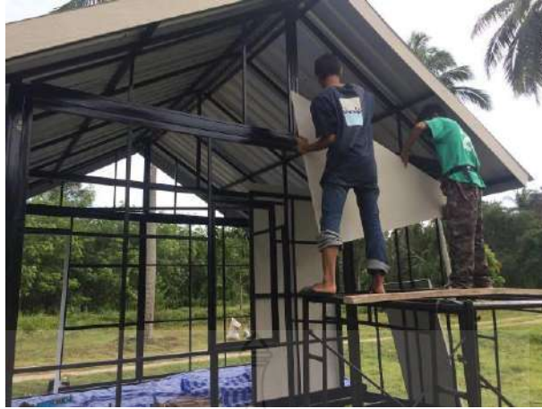
รูปที่ 21 การติดตั้งแผ่นหน้าจั่วเข้ากับโครงหน้าจั่วของบ้านถอดประกอบที่ขนส่งสะดวกเพื่อผู้ประสภักย์
