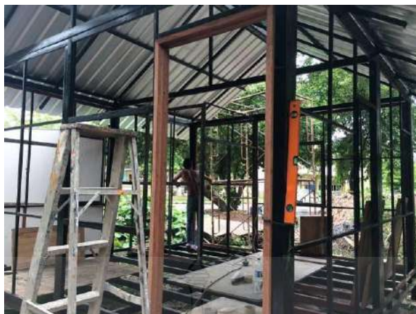
รูปที่ 4.22 การใช้ระดับน้ำเพื่อตรวจสอบแนวตั้งของโครงสร้างบ้านถอดประกอบที่ขนส่งสะดวก
