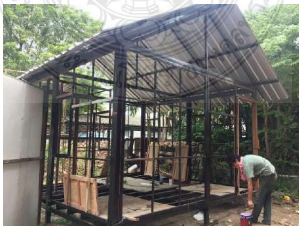
รูปที่ 9 การประกอบแป แผ่นหลังคาเหล็ก โครงผนัง และวงกบ
