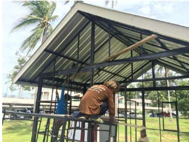
รูปที่ 19 การติดตั้งโครงหน้าจั่วของบ้านถอดประกอบที่ขนส่งสะดวกเพื่อผู้ประสพภัย
