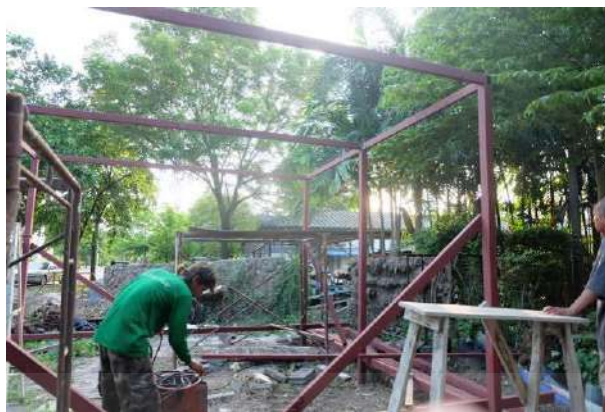
รูปที่ 4.16 การประกอบเสา คาน อะเส และชื้อเหล็กเป็นโครงสร้างหลัก
