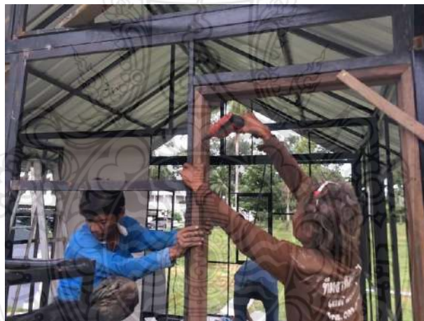
รูปที่ 20 การติดตั้งวงกบประตูโดยยึดเข้ากับโครงสร้างด้วยตะปูเกลียวปลายปล้อ
