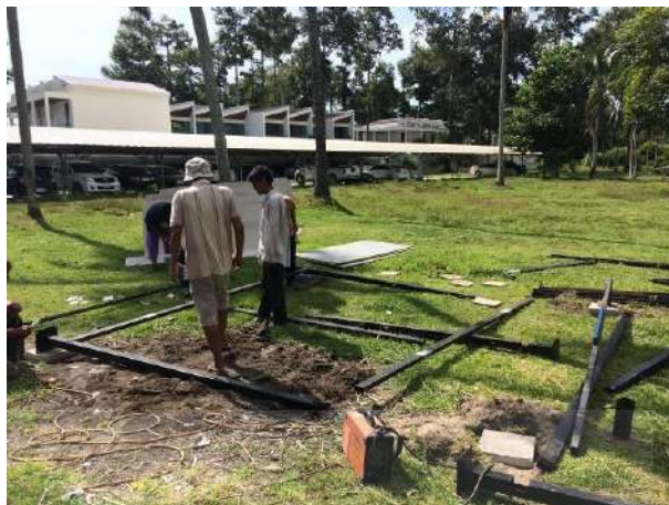
รูปที่ 4.38 การวางผังสำหรับก่อสร้างบ้านถอดประกอบที่ขนส่งสะดวกเพื่อผู้ประสบภัย
