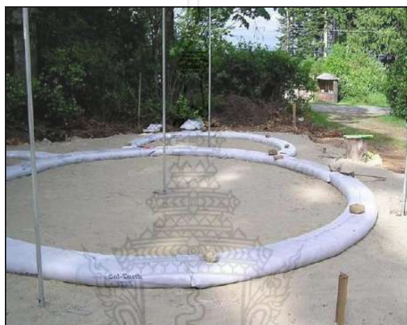
รูปที่ 2.1 ลักษณะการวางฐานรองรับโครงสร้างของบ้านพักอาศัยชั่วคราวที่สร้างด้วยระบบ Super Adobeของสถาปนิก Nader Khalili (สุธี, 2550)
