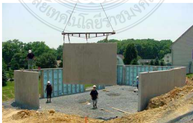
รูปที่ 1.2 การก่อสร้างโดยใช้ชิ้นส่วนคอนกรีตสำเร็จรูป
