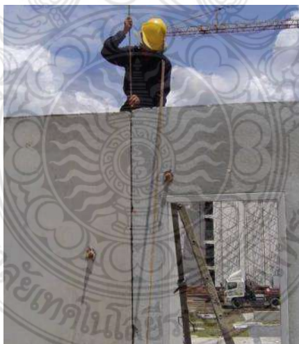
รูปที่ 2.25 การผสานชิ้นส่วนผนังสำเร็จแบบเปียกของโครงการเอื้ออาทรติวานนท์
