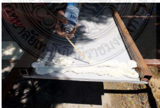
รูปที่ 3.31 การฉีดโฟมลงในช่องว่างระหว่างแผ่นมอร์ตาร์ทั้งสองด้านให้เต็ม
