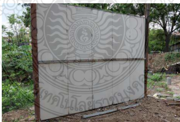
รูปที่ 4.21 ลักษณะผนังคอนกรีตสำเร็จรูปมวลเบาด้วยวิธีฉีดโฟมเป็นแกนกลางก่อนการฉาบ
