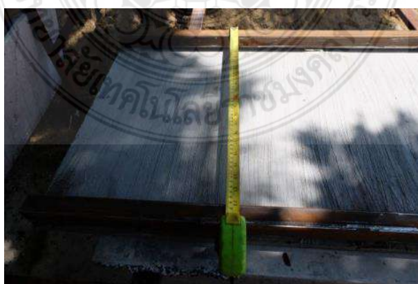
รูปที่ 3.28 การวัดขนาดของเหล็กกล่องที่วางบนแผ่นมอร์ตาร์สำหรับเป็นผนังสำเร็จรูป
