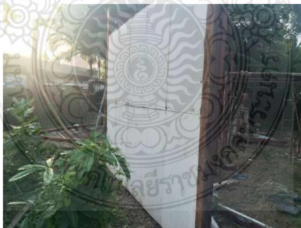
รูปที่ 23 ลักษณะผนังคอนกรีตสำเร็จรูปมวลเบาด้วยวิธีฉีดยาโฟมเป็นแกนกลางที่ก่อสร้างสมบูรณ์แล้ว
