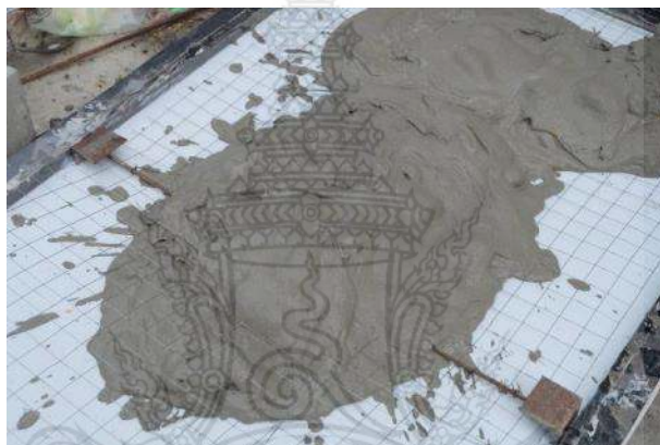
รูปที่ 3.21 การเทมอร์ตึ้งลงในแบบหล่อผนังสำเร็จรูปด้านนอกส่วนกลางที่มีการติดตั้งเหล็กตะแกรงเหล็กแผ่น และเหล็กเส้นไว้แล้ว
