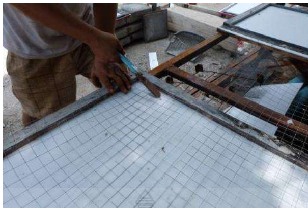
รูปที่ 3.17 การตัดและวางเหล็กตะแกรงลงในแบบหล่อพื้นผิวผนังสำเร็จรูปด้านนอก
