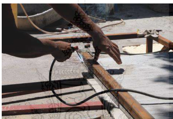
รูปที่ 3.30 การเชื่อมเหล็กกล่องรอบแผ่นมอร์ตาร์สำหรับเป็นผนังสำเร็จรูป
