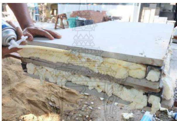
รูปที่ 3.38 การตกแต่งโฟมภายในช่องว่างให้สมบูรณ์โดยฉีดยาเพิ่ม
