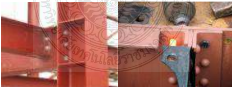
รูปที่ 2.3 รอยต่อของเหล็กรูปพรรณ
