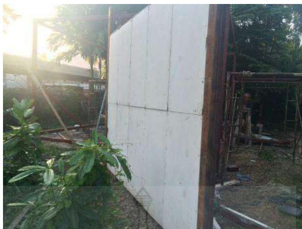
รูปที่ 4.22 ลักษณะผนังคอนกรีตสำเร็จรูปมวลเบาด้วยวิธีฉีดโฟมเป็นแกนกลางที่ก่อสร้างสมบูรณ์แล้ว
