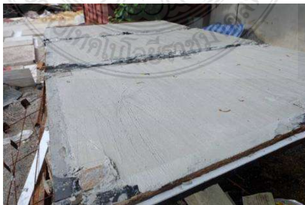
รูปที่ 3.25 การรอการแข็งตัวของแผ่นมอร์ตาร์ก่อนการถอดแบบ
