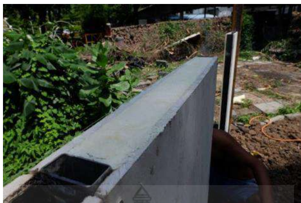
รูปที่ 4.19 ลักษณะการเชื่อมต่อกันของผนังคอนกรีตสำเร็จรูปมวลเบาด้วยวิธีฉีดโฟมเป็นแกนกลาง
