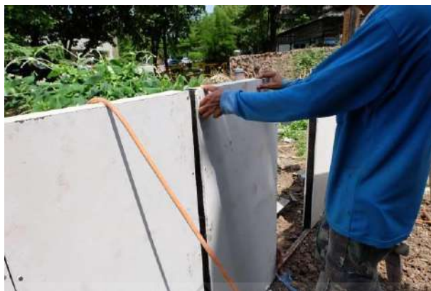
รูปที่ 21 การติดตั้งผนังคอนกรีตสำเร็จรูปมวลเบาด้วยวิธีฉีดยาโฟมเป็นแกนกลางต่อไปจนครบ
