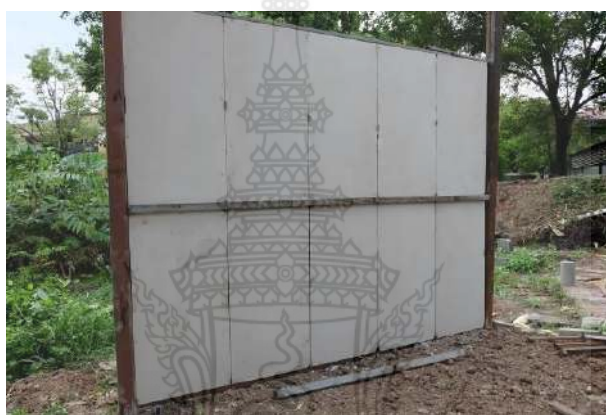
รูปที่ 22 ลักษณะผนังคอนกรีตสำเร็จรูปมวลเบาด้วยวิธีฉีดยาโฟมเป็นแกนกลางก่อนการฉาบ
