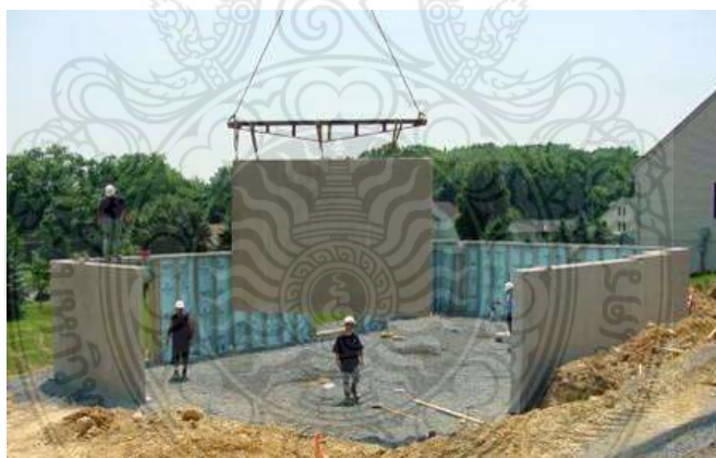
รูปที่ 1 การก่อสร้างโดยใช้ชิ้นส่วนคอนกรีตสำเร็จรูป
