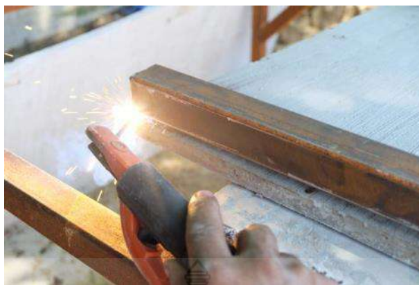
รูปที่ 3.29 การเชื่อมเหล็กกล่องบนแผ่นมอร์ตาร์สำหรับเป็นผนังสำเร็จรูป
