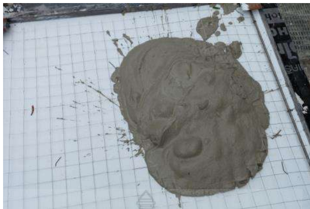
รูปที่ 3.20 การเทมอร์ตึ้งลงในแบบหล่อผนังสำเร็จรูปด้านนอกส่วนบนที่มีการติดตั้งเหล็กตะแกรงเหล็กแผ่น และเหล็กเส้นไว้แล้ว
