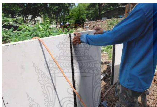
รูปที่ 4.20 การติดตั้งผนังคอนกรีตสำเร็จรูปมวลเบาด้วยวิธีฉีดโฟมเป็นแกนกลางต่อไปจนครบ
