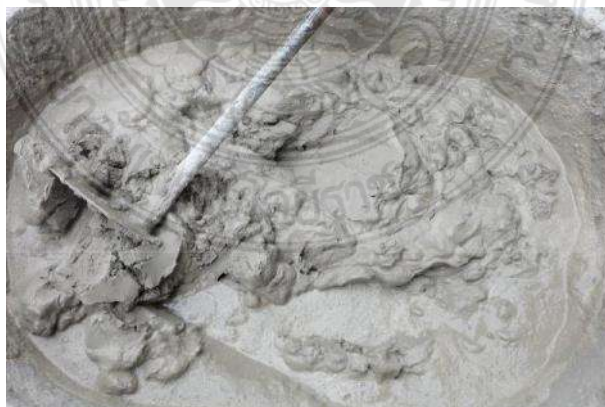
รูปที่ 3.19 การผสมมอร์ตาร์เพื่อใช้เป็นผนังสำเร็จรูปด้านนอก
