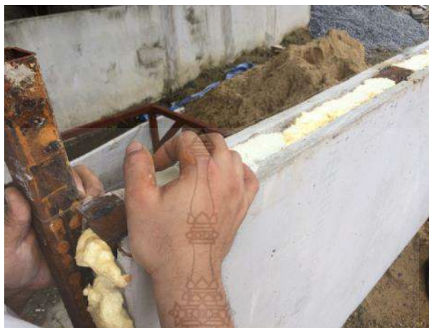
รูปที่ 3.49 การชั่งเอ็นสำหรับทดสอบความตรงของผนังคอนกรีตสำเร็จรูปมวลเบา
