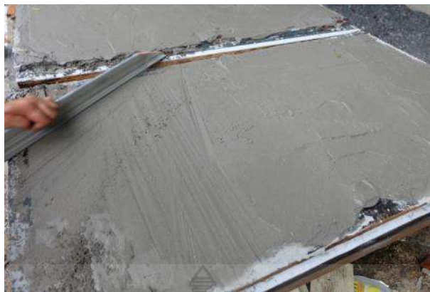
รูปที่ 3.23 การฉาบมอร์ตาร์ให้เรียบเพื่อใช้เป็นผนังสำเร็จรูปด้านนอกซึ่งภายในมีการติดตั้งเหล็กตะแกรงเหล็กแผ่น และเหล็กเส้น
