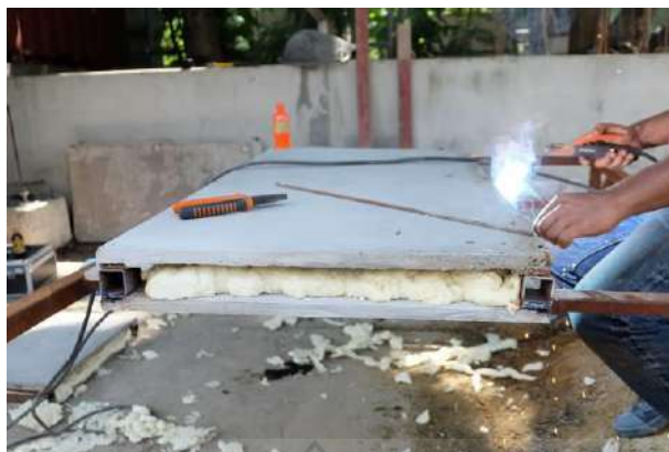
รูปที่ 7 การประกบและเชื่อมผนังสำเร็จรูปด้านนอกอีกด้านลงบนผนังที่มีการฉีดยาแล้ว
