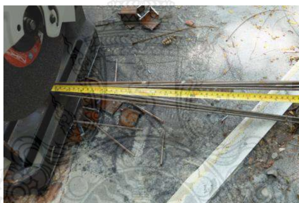
รูปที่ 3.4 การตัดเหล็กเส้นกลมให้ได้ความยาวตามต้องการ
