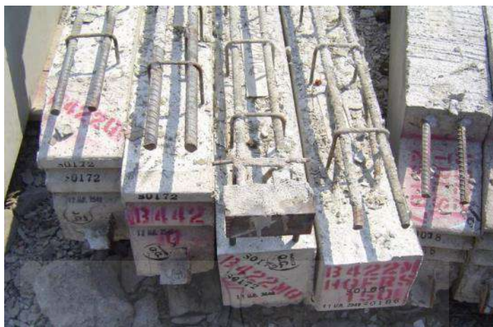
รูปที่ 2.28 ลักษณะการฝังเหล็กเพลาตัวที่คานขอยสำหรับเชื่อมต่อกับคานหลัก
