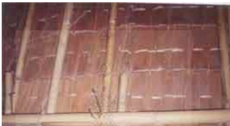
ภาพที่ 2.13 แสดงลักษณะของจาก (ใช้มุงหลังคา) ลักษณะหลังคา หลังคาแหลม หน้าจั่วสูง
