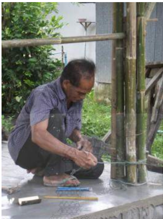
ภาพที่ 2.27 แสดงลักษณะของการผูกเสาเรือน
