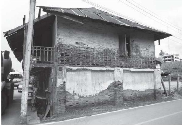
ภาพที่ 4.8 บ้านเลขที่ 181 ในตัวอำเภอ เชียงคาน จังหวัดเลย แสดงการเสื่อมสภาพ ของฝาไม้ไผ่ฉาบปูน ที่ส่วนล่างของผนัง ซึ่งพื้นแนวกั้นสาดเป็นส่วนที่ปูนฉาบจะ หลุดออกก่อน หากไม่เร่งฉาบปูนทับใหม่ ทั้งผนังก็จะผุพัง อาจถึงขั้นต้องรื้อ เปลี่ยนใหม่อย่างน่าเสียดาย (ธาดา สุทธิธรรม 2554)
