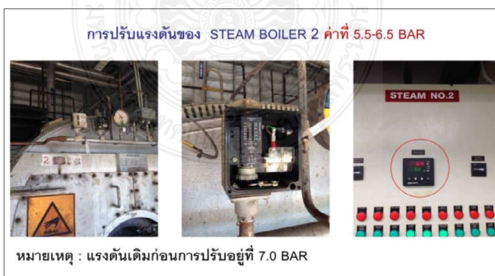
ภาพ 5.4 การปรับแรงดันหม้อน้ำ (Boiler) No. 2 ที่ค่า 5.5-6.5 บาร์
