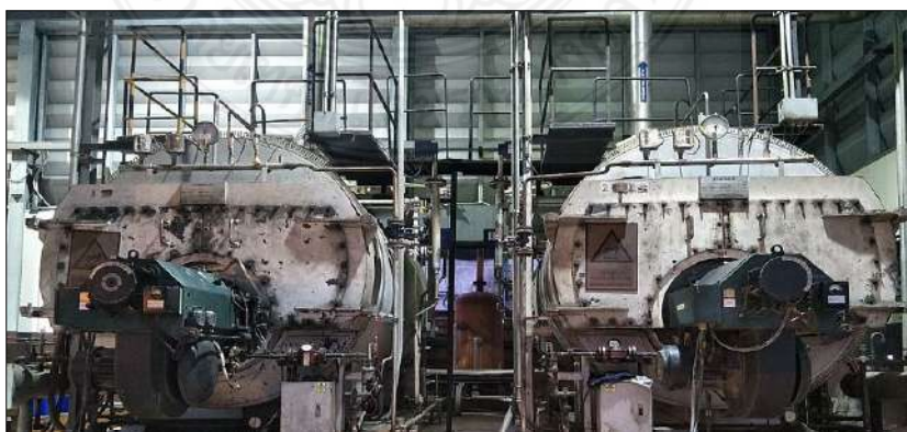
ภาพ 5.2 หม้อน้ำ(Boiler) ขนาด 3 ตันต่อชั่วโมง จำนวน 2 ชุด ขององค์กรกรณีศึกษา
