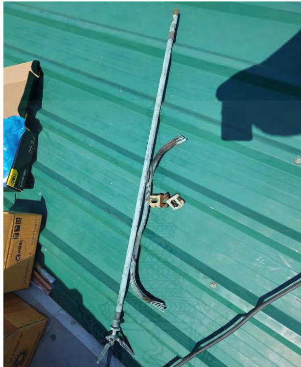
รูปที่ 4.8 ถอดเสาและรื้อถอนระบบป้องกันฟ้าผ่าเก่า
