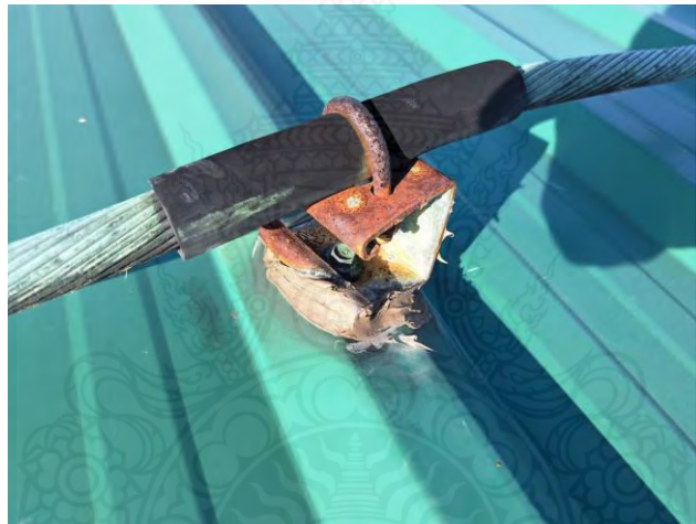
รูปที่ 3.4 ตัวจับยึดสายตัวนำ
