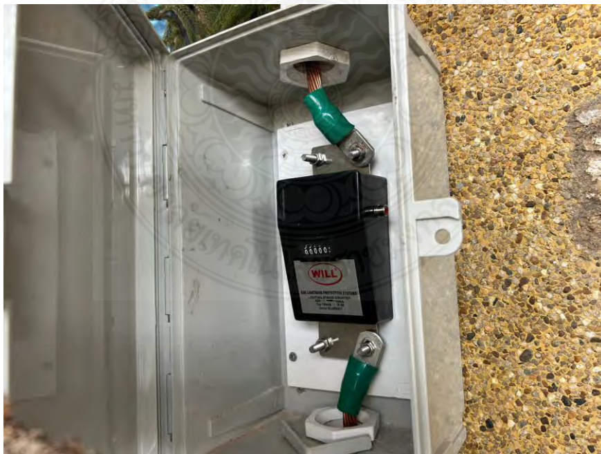
รูปที่ 4.12 งานติดตั้ง Ground Test Box
