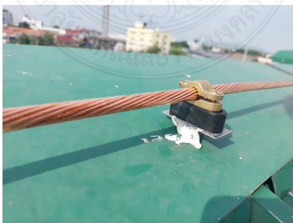
รูปที่ 4.11 การติดตั้งสายตัวนำ
