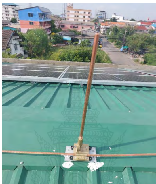
รูปที่ 4.10 การติดตั้งแท่งตัวนำ
