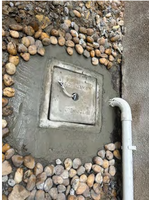
รูปที่ 4.13 งานติดตั้งบ่อกราวด์คอนกรีต
