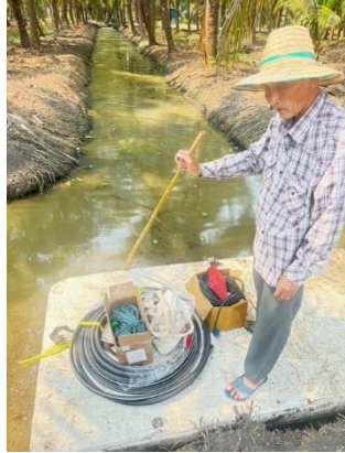
รูปการเตรียมอุปกรณ์ในการติดตั้ง
