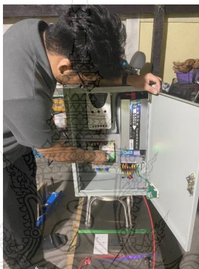
รูปที่ 3.5 การเชื่อมต่อระบบสำรองไฟฟ้าเข้ากับครัวเรือน
