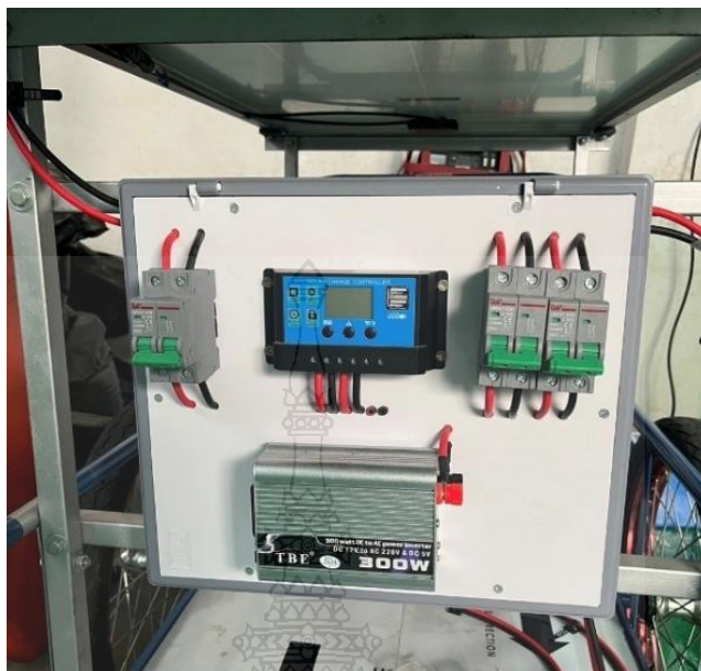
รูปที่ 3.6 การติดตั้งแผงวงจรบนตัวรถเข็น
