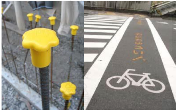
ภาพที่ 2.17 อุปกรณ์ฝากรอบเหล็กเส้น และการแบ่งช่องทางการสัญจร
