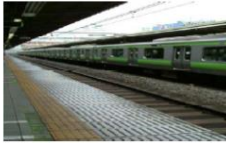
ภาพที่ 2.11 แผ่นพื้นสำหรับคนพิการทางสายตา
