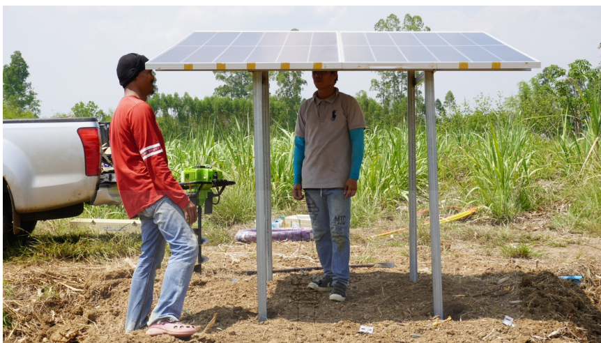
ภาพที่ ก.15 การติดตั้งแผงเซลล์แสงอาทิตย์ ณ ตำบลคลองหินปูน อำเภอวังน้ำเย็น จังหวัดสระแก้ว
