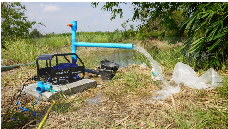
ภาพที่ 3.11 งานติดตั้งปั้มน้ำ
