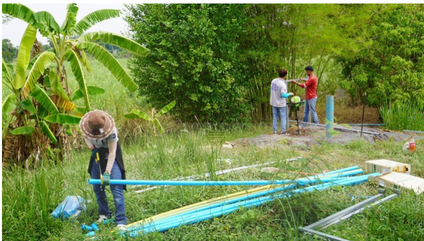
ภาพที่ ก.3 การเตรียมอุปกรณ์ก่อนการติดตั้งระบบผลิตไฟฟ้าพลังงานแสงอาทิตย์ ณ ตำบลตาหลังใน อำเภอวังน้ำเย็น จังหวัดสระแก้ว
