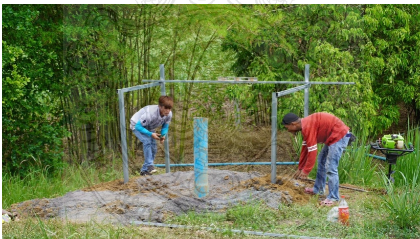
ภาพที่ ก.4 งานติดตั้งโครงสร้างรองรับแผงเซลล์แสงอาทิตย์ ณ ตำบลตาหลังใน อำเภอวังน้ำเย็น จังหวัดสระแก้ว
