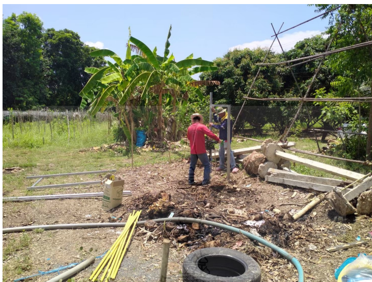
ภาพที่ ก.7 การปรับพื้นที่ก่อนการติดตั้งระบบผลิตไฟฟ้าพลังงานแสงอาทิตย์ ณ ตำบลทุ่งมหาเจริญ อำเภอวังน้ำเย็น จังหวัดสระแก้ว
