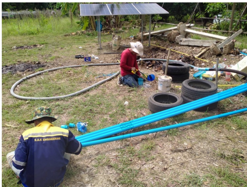
ภาพที่ ก.9 การเตรียมอุปกรณ์ก่อนการติดตั้งระบบผลิตไฟฟ้าพลังงานแสงอาทิตย์ ณ ตำบลทุ่งมหาเจริญ อำเภอลำทะเมนชัย จังหวัดสระบุรี
