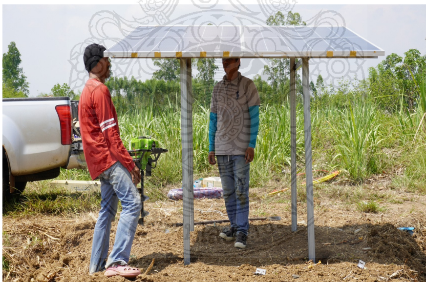
ภาพที่ 3.10 งานติดตั้งแผงเซลล์แสงอาทิตย์
