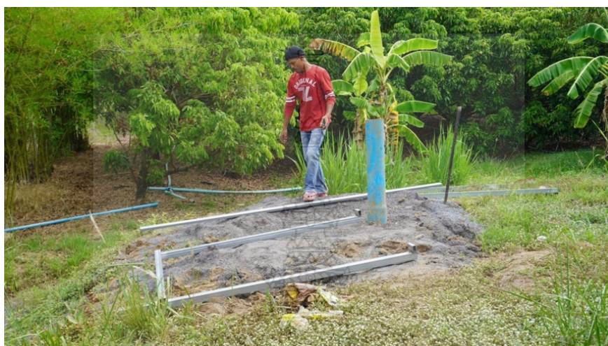
ภาพที่ ก.1 การปรับพื้นที่ก่อนการติดตั้งระบบผลิตไฟฟ้าพลังงานแสงอาทิตย์ ณ ตำบลตาหลังใน อำเภอวังน้ำเย็น จังหวัดสระแก้ว
