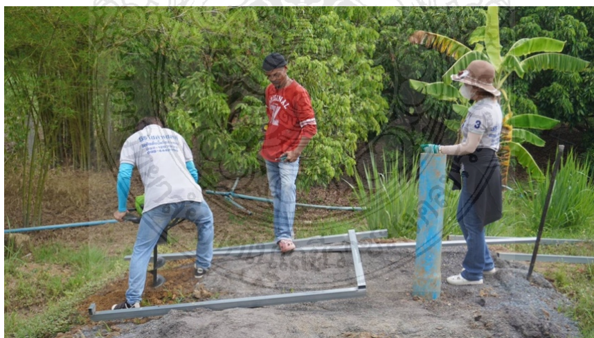
ภาพที่ ก.2 การเตรียมพื้นที่ก่อนการติดตั้งระบบผลิตไฟฟ้าพลังงานแสงอาทิตย์ ณ ตำบลตาหลังใน อำเภอวังน้ำเย็น จังหวัดสระแก้ว
