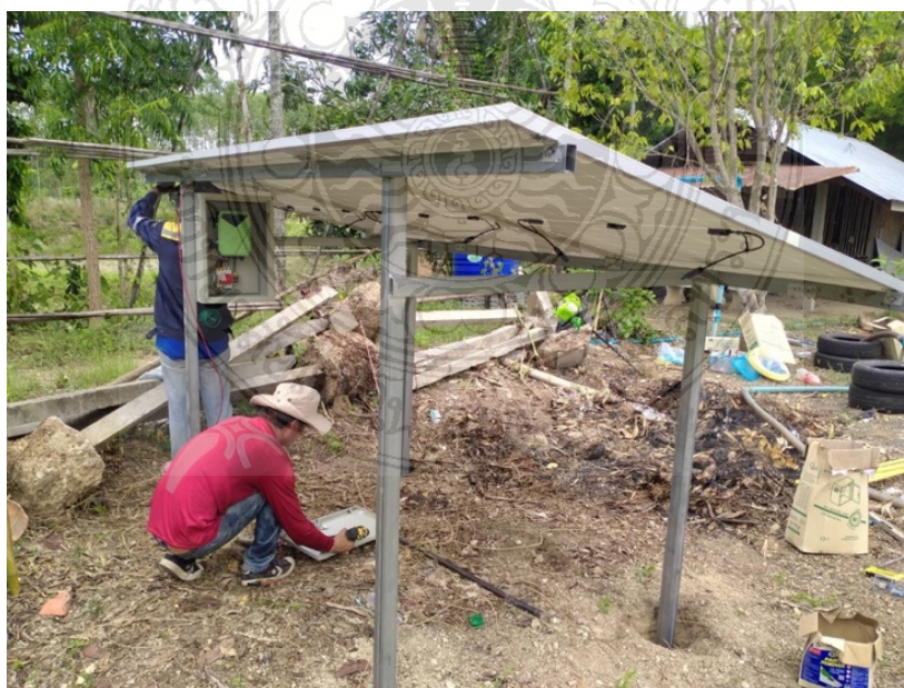
ภาพที่ ก.10 งานติดตั้งโครงสร้างรองรับแผงเซลล์แสงอาทิตย์ ณ ตำบลทุ่งมหาเจริญ อำเภอลำทะเมนชัย จังหวัดสระบุรี
