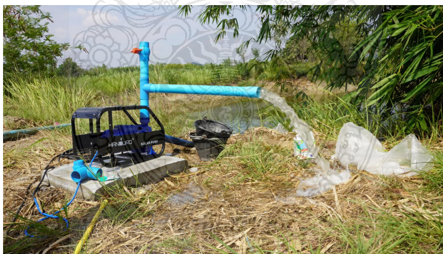
ภาพที่ ก.16 การติดตั้งปั้มน้ำหอยโข่ง ณ ตำบลคลองหินปูน อำเภอวังน้ำเย็น จังหวัดสระแก้ว
