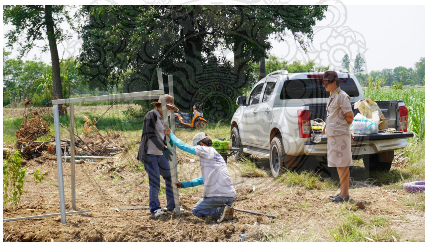
ภาพที่ ก.14 งานติดตั้งโครงสร้างรองรับแผงเซลล์แสงอาทิตย์ ตำบลคลองหินปูน อำเภอวังน้ำเย็น จังหวัดสระแก้ว
