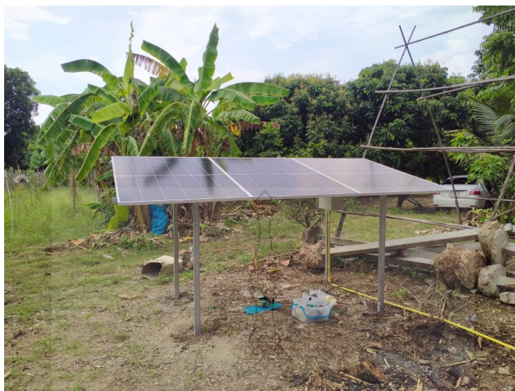
ภาพที่ ก.11 การติดตั้งแผงเซลล์แสงอาทิตย์ ณ ตำบลทุ่งมหาเจริญ อำเภอวังน้ำเย็น จังหวัดสระแก้ว
