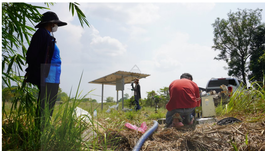
ภาพที่ ก.13 การเตรียมอุปกรณ์ก่อนการติดตั้งระบบผลิตไฟฟ้าพลังงานแสงอาทิตย์ ตำบลคลองหินปูน อำเภอวังน้ำเย็น จังหวัดสระแก้ว
