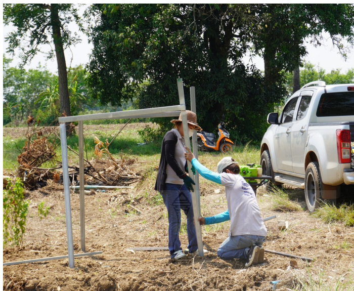
ภาพที่ 3.9 งานติดตั้งโครงสร้างรองรับแผงเซลล์แสงอาทิตย์
