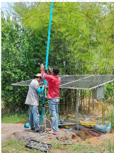
ภาพที่ ก.6 การติดตั้งปั้มน้ำซับเมอร์ส ณ ตำบลตาหลังใน อำเภอวังน้ำเย็น จังหวัดสระแก้ว
