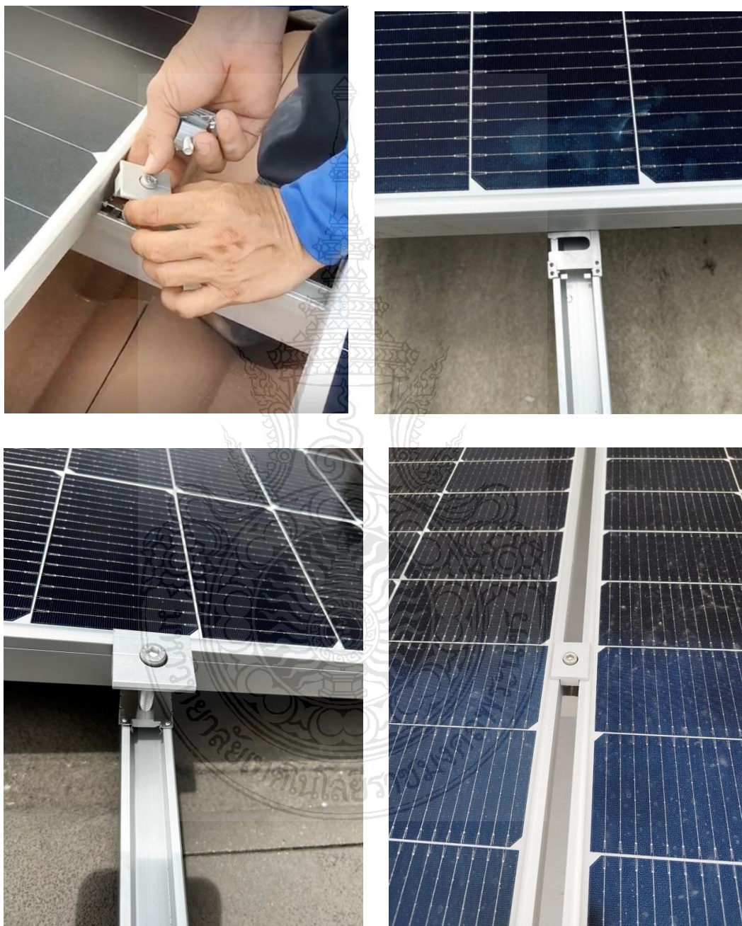
รูปที่ ๓.๙ การติดตั้งอุปกรณ์จับยึดระหว่างแผงเซลล์แสงอาทิตย์
