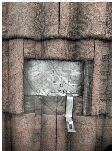
รูปที่ ๓.๒ การติดตั้งอุปกรณ์ยึดหลังคา
