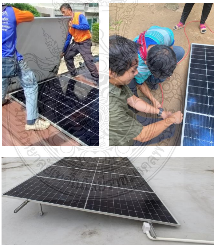
รูปที่ ๓.๘ การติดตั้งแผงเซลล์แสงอาทิตย์
