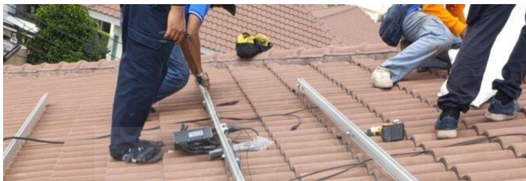
รูปที่ ๓.๗ การติดตั้งอินเวอร์เตอร์
