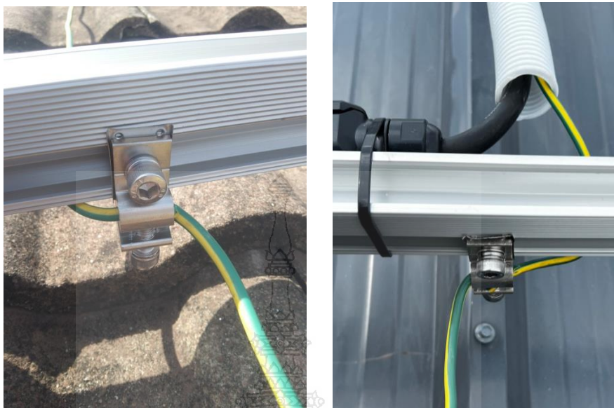
รูปที่ ๓.๖ การติดตั้งอุปกรณ์จับยึดสายกราวด์
