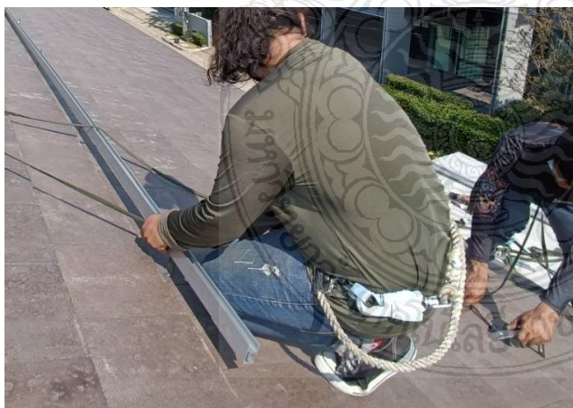
รูปที่ ๓.๔ การติดตั้งรางยึดแผงเซลล์แสงอาทิตย์
