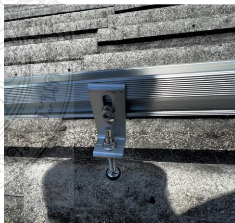
รูปที่ ๓.๔ การติดตั้งรางยึดแผงเซลล์แสงอาทิตย์
