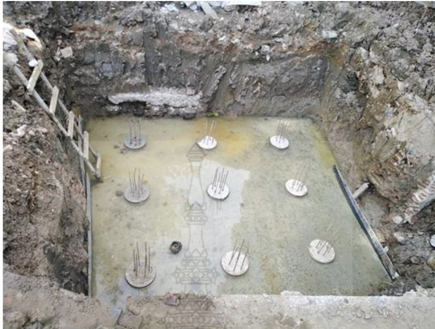
รูปที่ 4.4 ตำแหน่งเสาเข็มของฐานรากลิฟต์ที่เชียงใหม่
