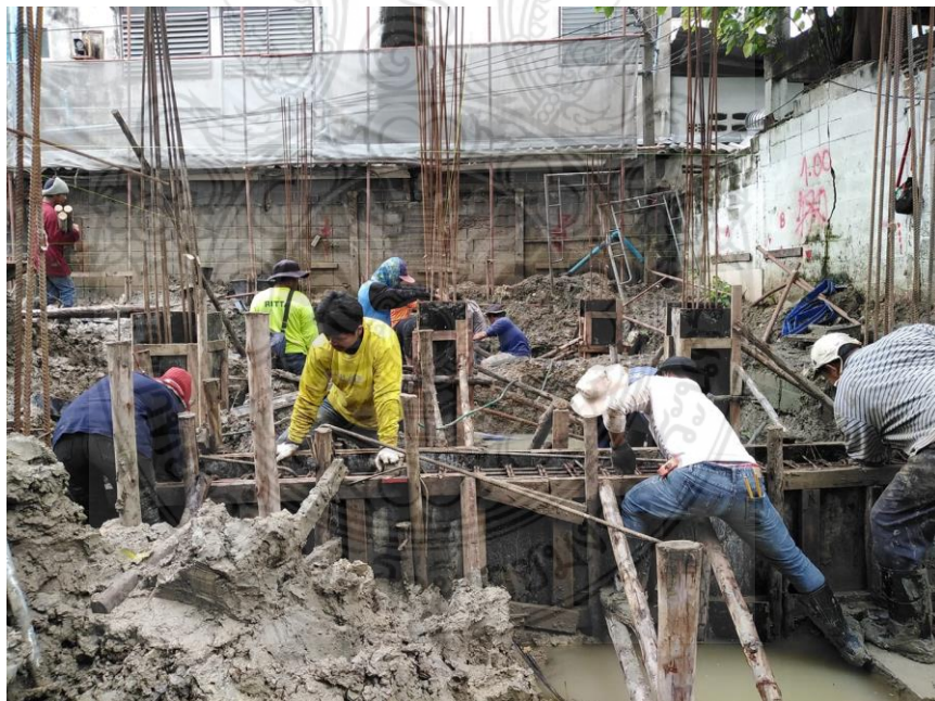
รูปที่ 4.5 การแก้ไขกรณีเสาเข็มเชียงใหม่โดยวิธีออกแบบคานยึดระหว่างฐานราก
