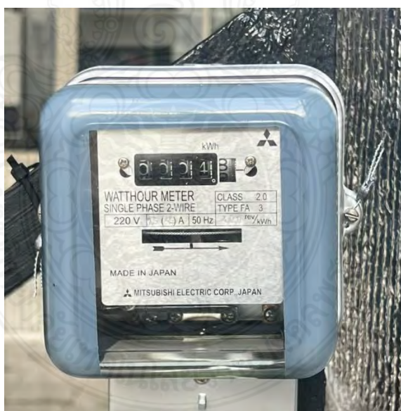
รูปที่ 4.15 บันทึกค่าปริมาณกำลังไฟฟ้าที่ใช้
