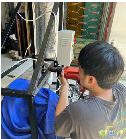
รูปที่ 3.3 เจาะโครงเพื่อติดเบรกเกอร์ และมอเตอร์วัดหน่วยไฟฟ้า
