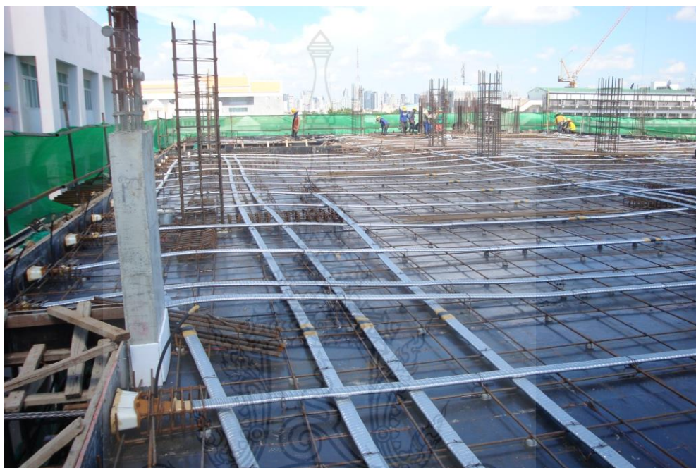
รูปที่ 4.1 โครงสร้างพื้น Post – tension ของโครงการที่ศึกษา
