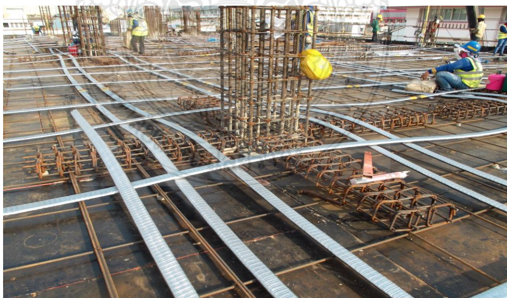
รูปที่ 4.2 รูปแบบการเสริมเหล็กรับแรงเฉือนที่หัวเสา ของโครงการที่ศึกษา
