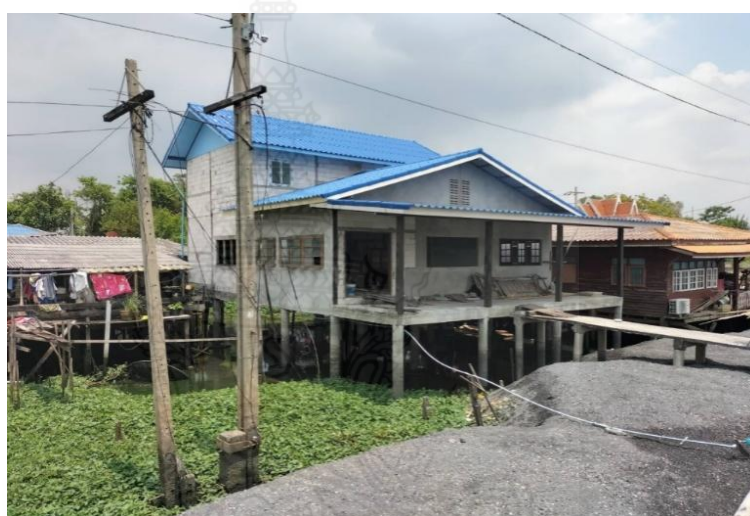
ภาพที่ 4.3 การปรับเปลี่ยนโครงสร้างบ้านพักอาศัยริมน้ำ
