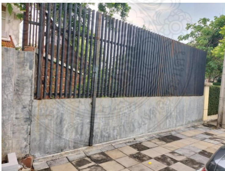
ภาพที่ 4.9 สร้างกำแพงปิดกั้นลำรางสาธารณะ
