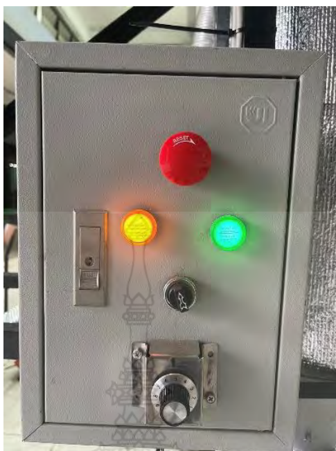
รูปที่ 3.9 เปิดฮีตเตอร์และปรับอุณหภูมิที่จะทำการอบ
