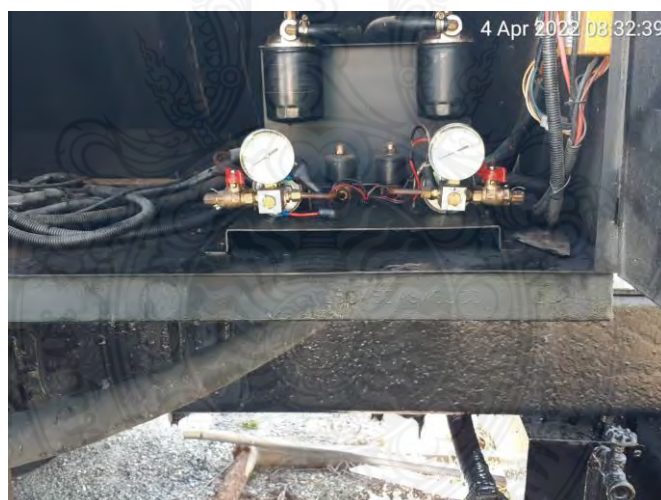
รูปที่ ก.4 ตรวจสอบปั้มน้ำมันเชื้อเพลิง
