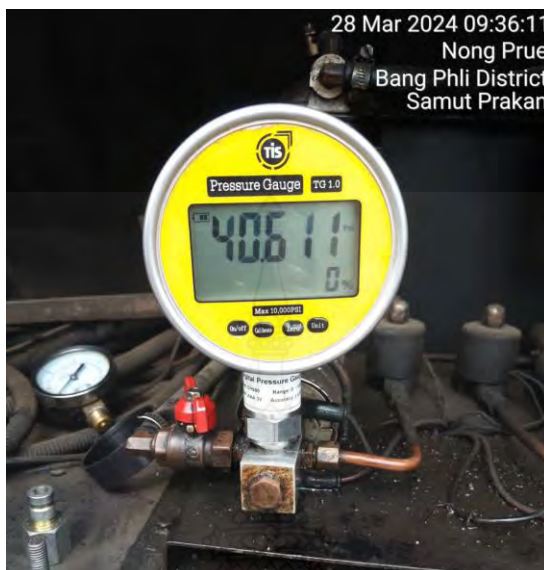
รูปที่ 2.11 ชุดควบคุมปรับระดับความดันเชื้อเพลิง
