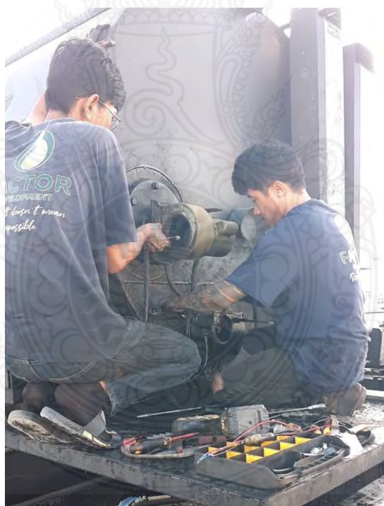
รูปที่ ก.2 ตรวจสอบทำความสะอาดพัดลมอัดอากาศ
