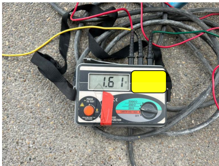
รูปที่ 4.24 เครื่องทดสอบความต้านทานดินบนหลังคาขนาด 25.68 kWp
