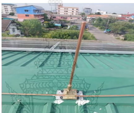
รูปที่ 4.15 การติดตั้งแท่งตัวนำ
