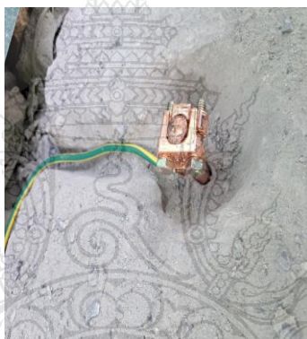
รูปที่ 4.21 งานติดตั้งแท่งตัวนำลงดิน
