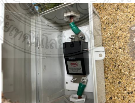
รูปที่ 4.17 งานติดตั้ง Ground Test Box
