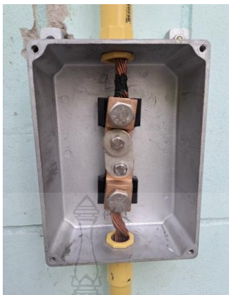
รูปที่ 4.20 งานติดตั้ง Ground Test Box อาคารขนาด 149.80 kWp
