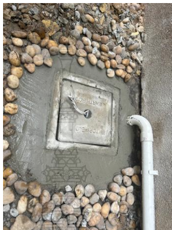
รูปที่ 4.18 งานติดตั้งบ่อกราวด์คอนกรีต
