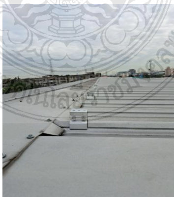
รูปที่ 4.19 งานติดตั้งแท่นยึดตัวนำ
