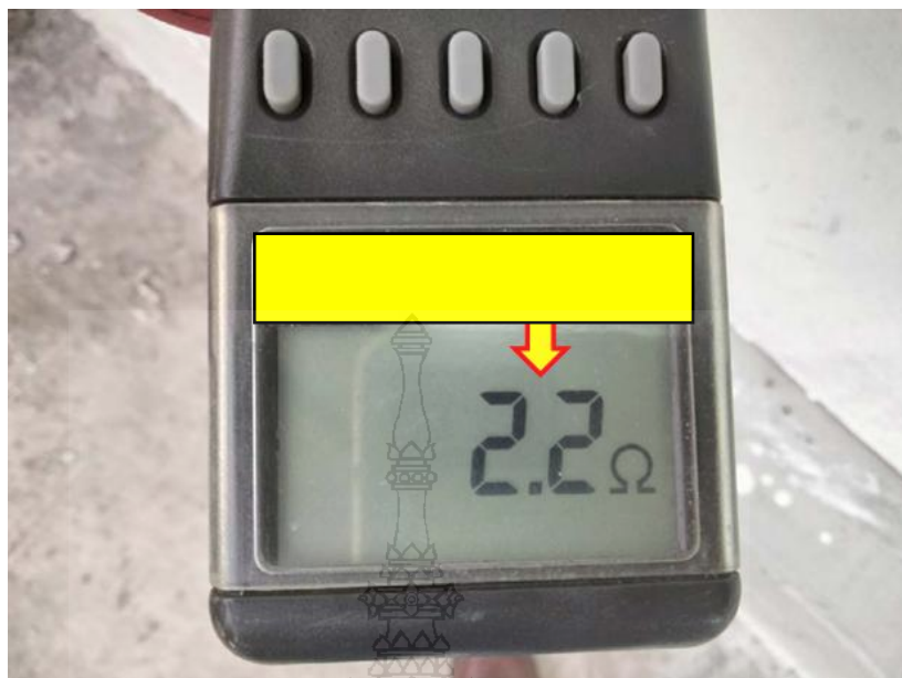
รูปที่ 4.25 ผลลัพธ์การวัดเครื่องทดสอบความต้านทานดินบนหลังคาขนาด 149.80 kWp
