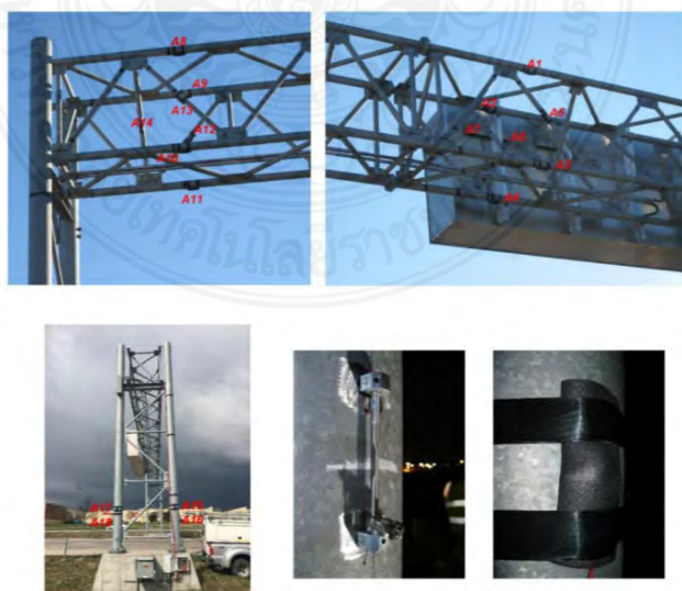
รูปที่ 2.12 การติดตั้งเซนเซอร์เพื่อบันทึกผล [10]
