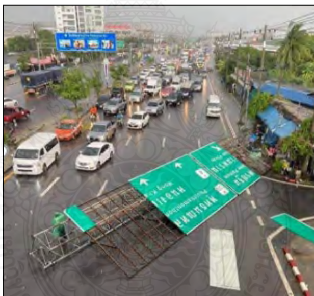
รูปที่ 1.6 ป้ายแนะนำทางที่เกิดความเสียหายที่เกิดจากลม [6]
