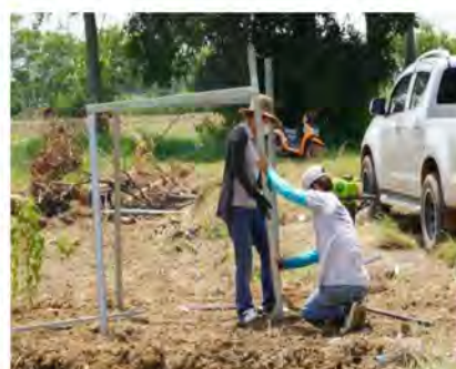
ภาพที่ 10 งานติดตั้งโครงสร้างรองรับแผงเซลล์แสงอาทิตย์
