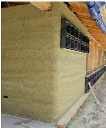
ภาพที่ 2.23 อิฐคอนกรีตจากใบป่าน “Hempcrete”
